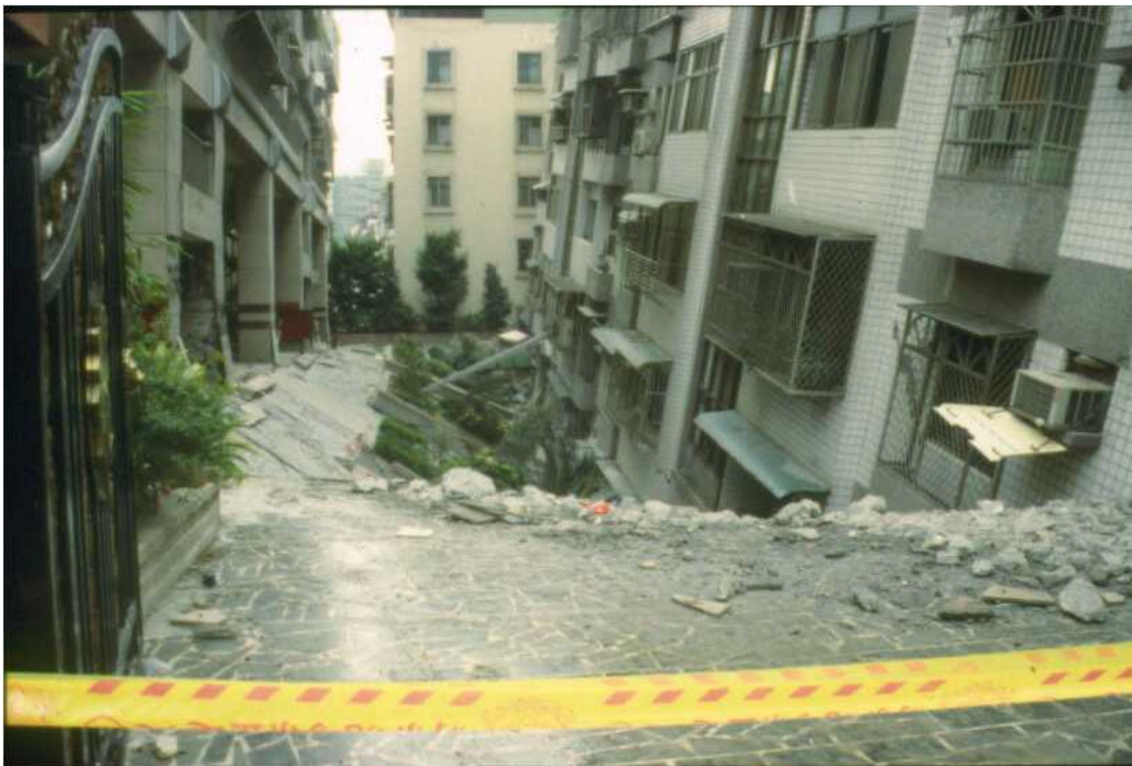
圖 4.4 一樓開放空間設計的大樓在地震時倒塌的實例
