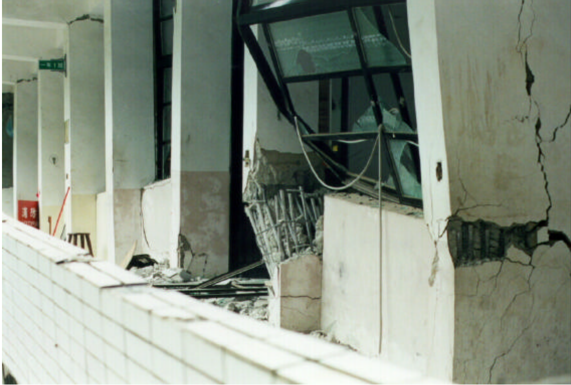
圖 4.6 學校教室因不當的窗台設計與施工細節，常造成短柱效應而破壞
